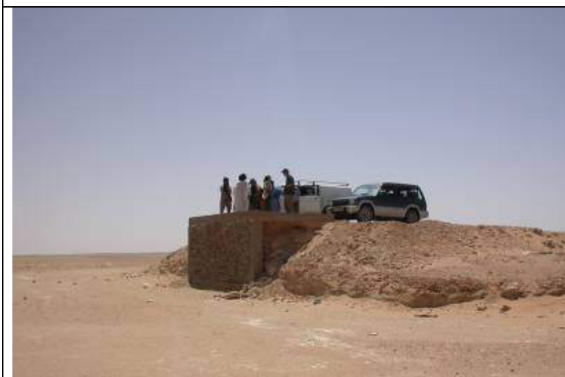
Estación de transferencia, Smara. Para ser utilizada para cargar los camiones directamente de los volquetes para permitir que la basura sea llevada al Nuevo vertedero
